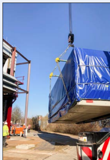
Der 70 Tonnen schwere Container mit der darin verbauten Gasturbine schwebt am Kran Foto: Stadtwerke
