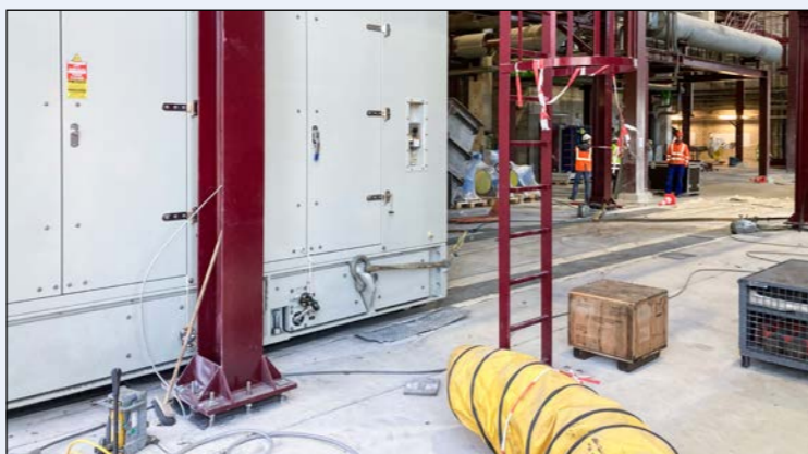
Von einer Seilwinde gezogen bewegt sich die erste der beiden 70 Tonnen schweren Gasturbinen auf speziellen Schwerlastrollen in das Kraftwerksgebäude hinein
