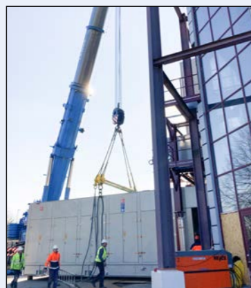
Trotz des enormen Gewichts der Turbinen ist millimetergenaue Arbeit gefragt
