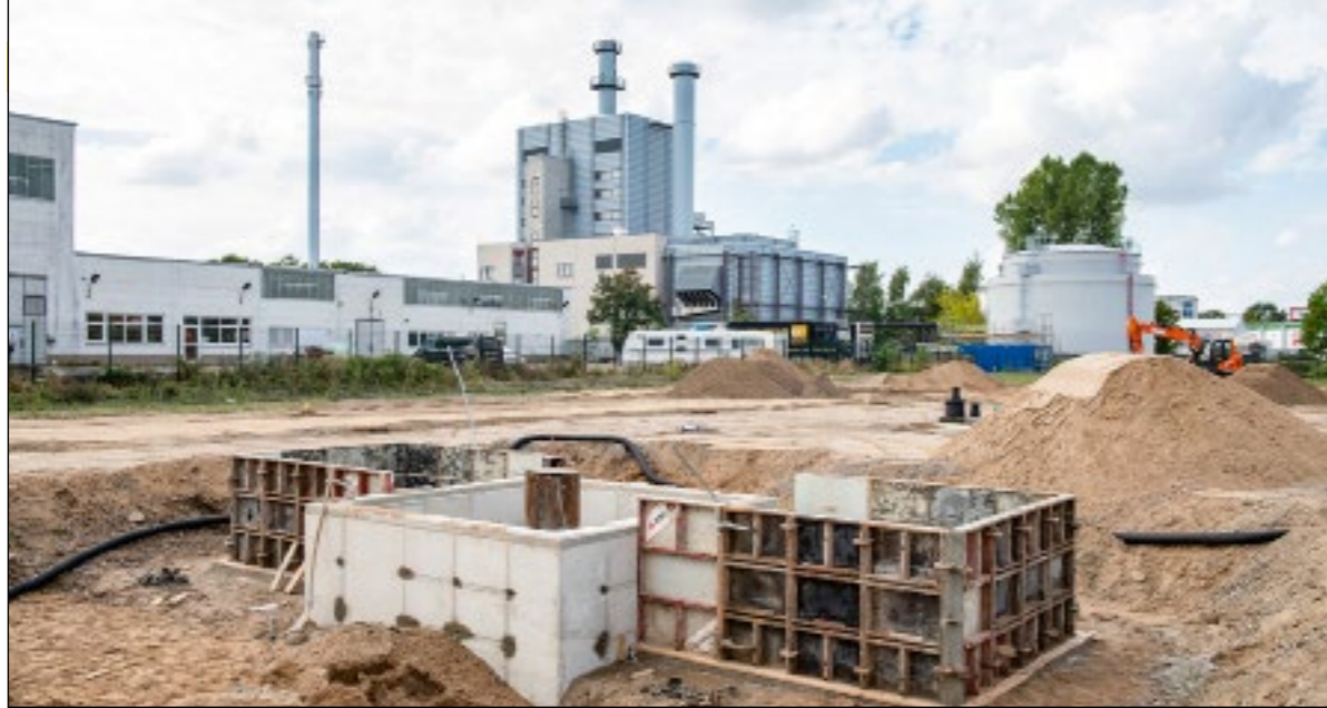
In unmittelbarer Nähe zum Heizkraftwerk der EVSE entsteht das erste Bohrloch für das Erdwärmeverhaben
