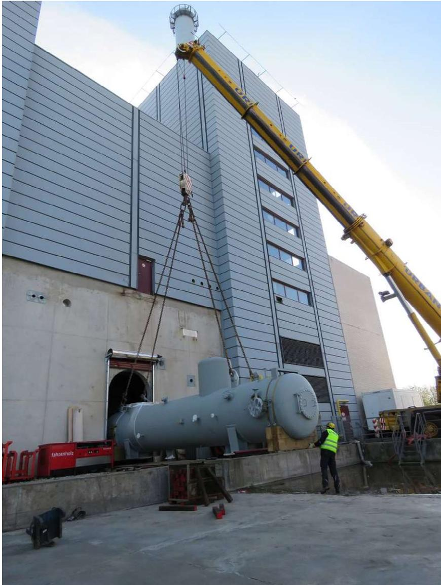
BU: Millimetergenau wird der 27 Tonnen schwere Heizkondensator in die Kraftwerkshalle gehievt.
