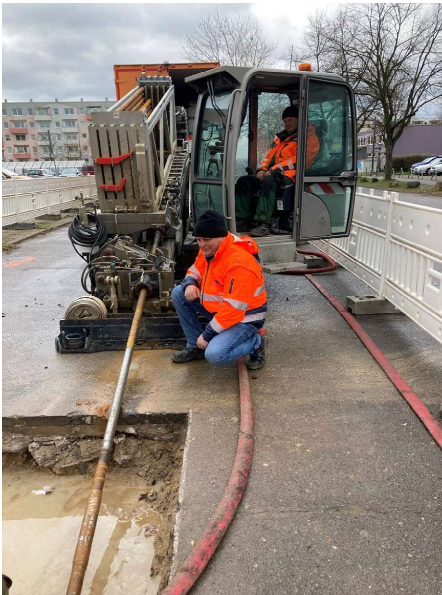
BU: René Rüdiger, Projektleiter Geothermie der Stadtwerke Schwerin, überwacht die gelenkte Horizontalbohrung unter der Ratzeburger Straße hindurch
