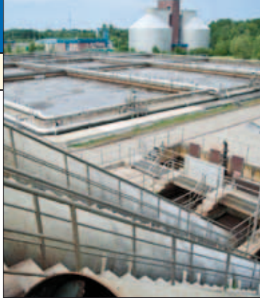
Die Kläranlage produziert bis zu 50 Prozent ihres Stroms selbst Foto: Klaus Schimmagk
