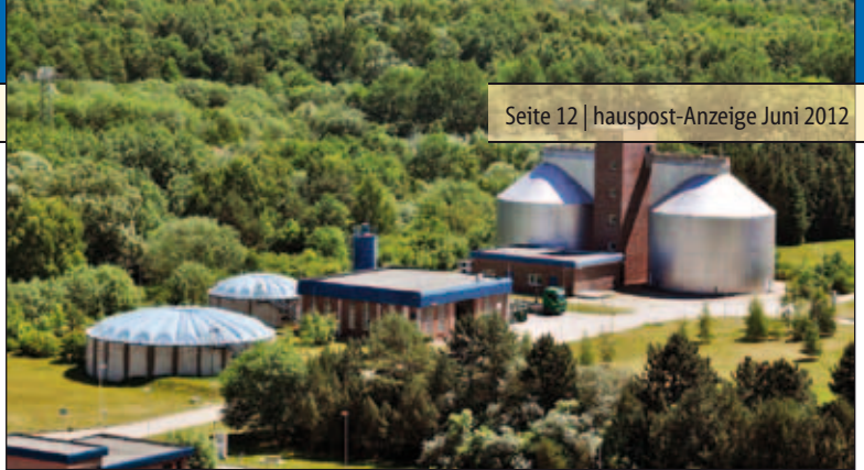
Jede Menge freie Dächer - auf der Kläranlage Schwerin Süd wären Fotovoltaikanlagen zur Stromerzeugung denkbar Foto: Egbert Buchberger/MV-Foto e. V.
