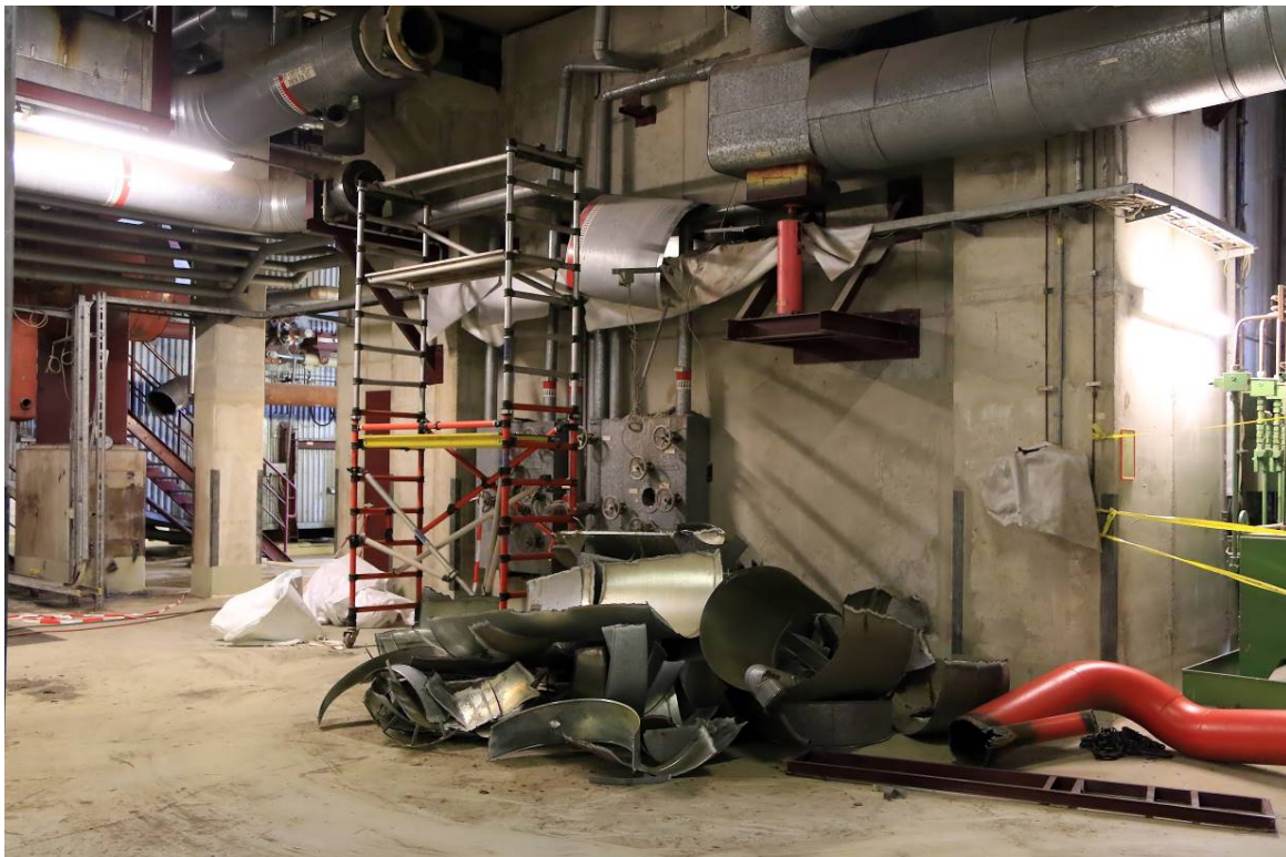
BU: Vor allem thermisch hoch belastete Baugruppen werden im HKW Süd ersetzt
