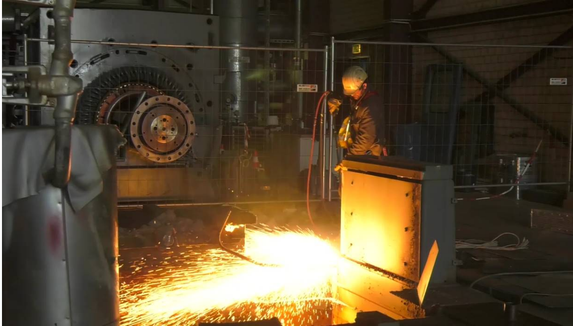
BU: Ein Spezialunternehmen führt die Demontagerbeiten am HKW Süd durch
