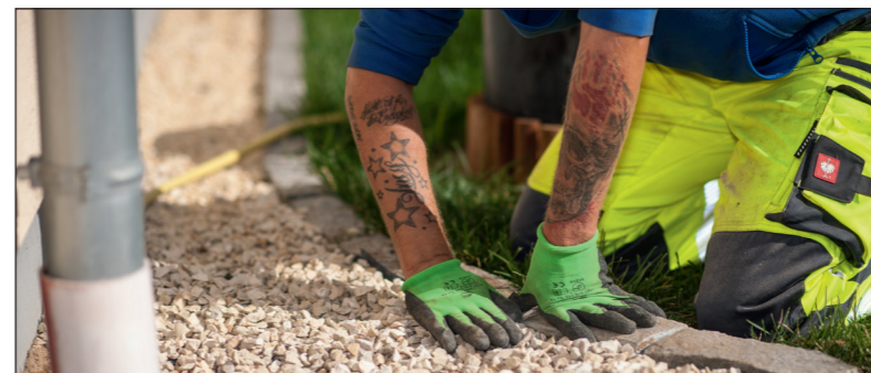
Nach Abschluss aller Bauarbeiten werden die Oberflächen auf dem Grundstück sowie auf Gehwegen und Straßen in den ursprünglichen Zustand gebracht
