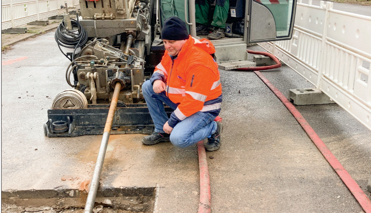
René Rüdiger, Projektleiter Geothermie der Stadtwerke Schwerin, überwacht den Baufortschritt
