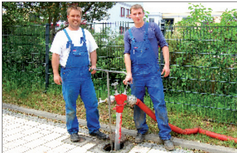
Die Anlagenmechaniker Tom Freitag und Dennis Michel (v.l.) spülen, wie hier in der Vidiner Straße in Neu Zippendorf, regelmäßig die Trinkwasserrohre durch Foto: maxpress/mw
