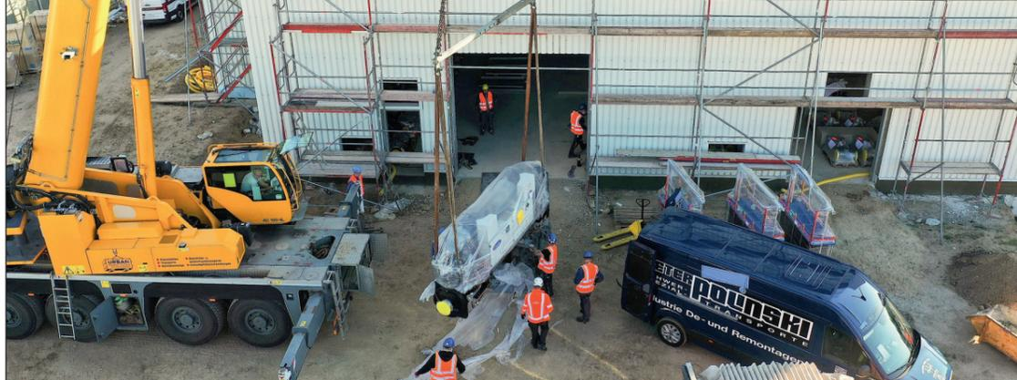
Mit einem Mobilkran wurden die vier neuen Wärmepumpen auf Schwerlastrollen verladen und anschließend in der Geothermie-Zentrale installiert
