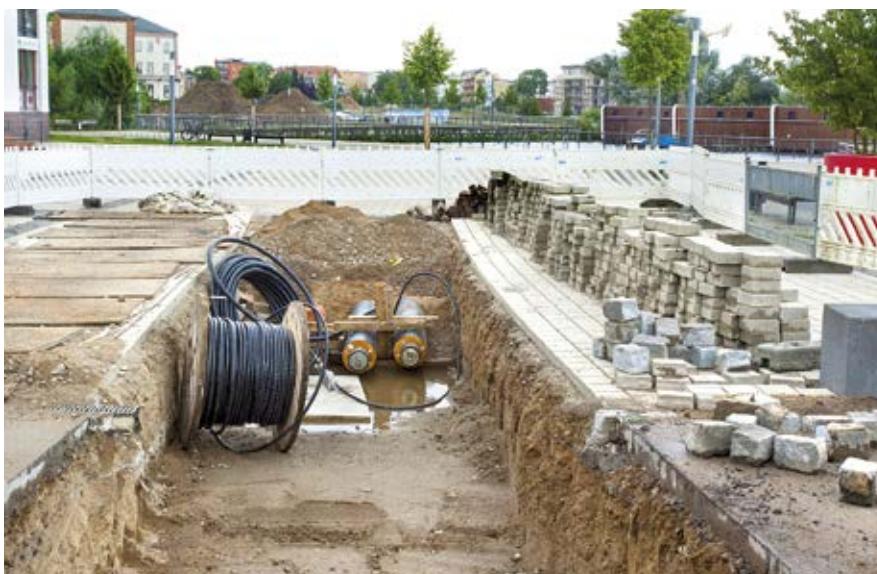
Parallele Verlegung von Glasfaser- und Fernwärmeleitungen
