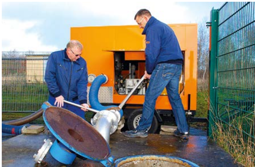
WAG-Mitarbeiter koppeln Schläuche, um die Steigleitung im Pumpwerk Schliemannstraße zu erneuern
